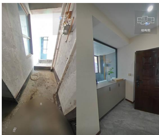
图1 新恒基翡翠城住宅小区玄关改造前后
